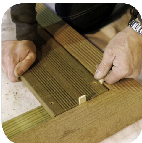
Placement des cales
