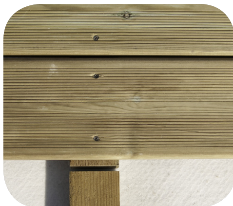
Aboutage des lambourdes
